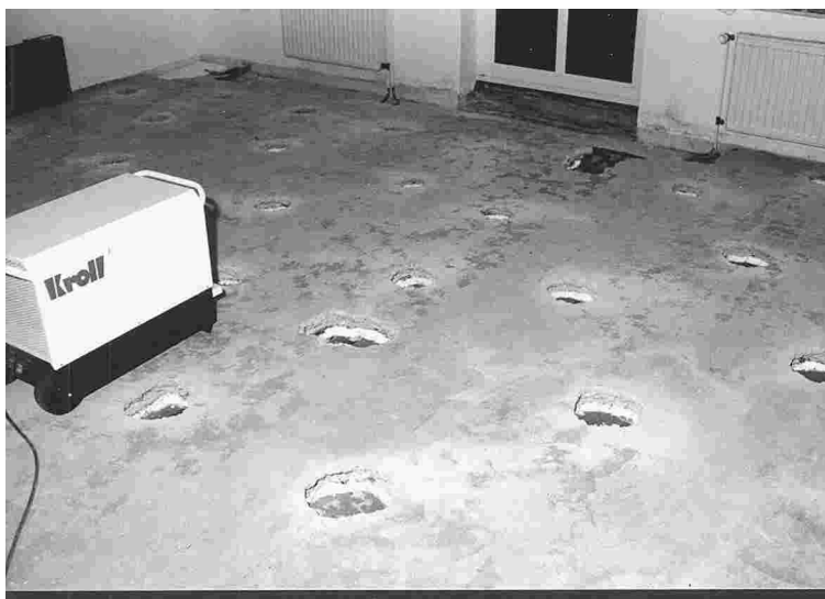
SPEZIAL- ESTRICHTROCKNUNG EMMENTALER PATENT
